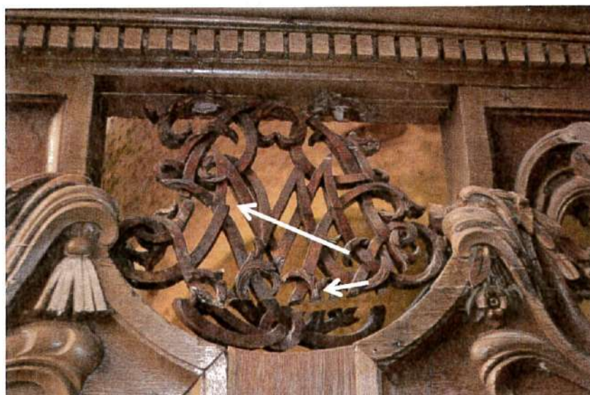
Figure 2 : monogramme. Les flèches montrent des exemples de ruptures des joints de collage NUM20181221
